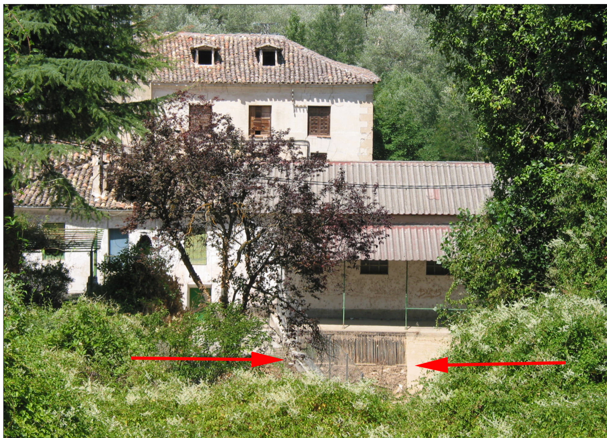
Viejas estructuras pertenecientes a la Ceca, con el canal de entrada de agua señalada.
