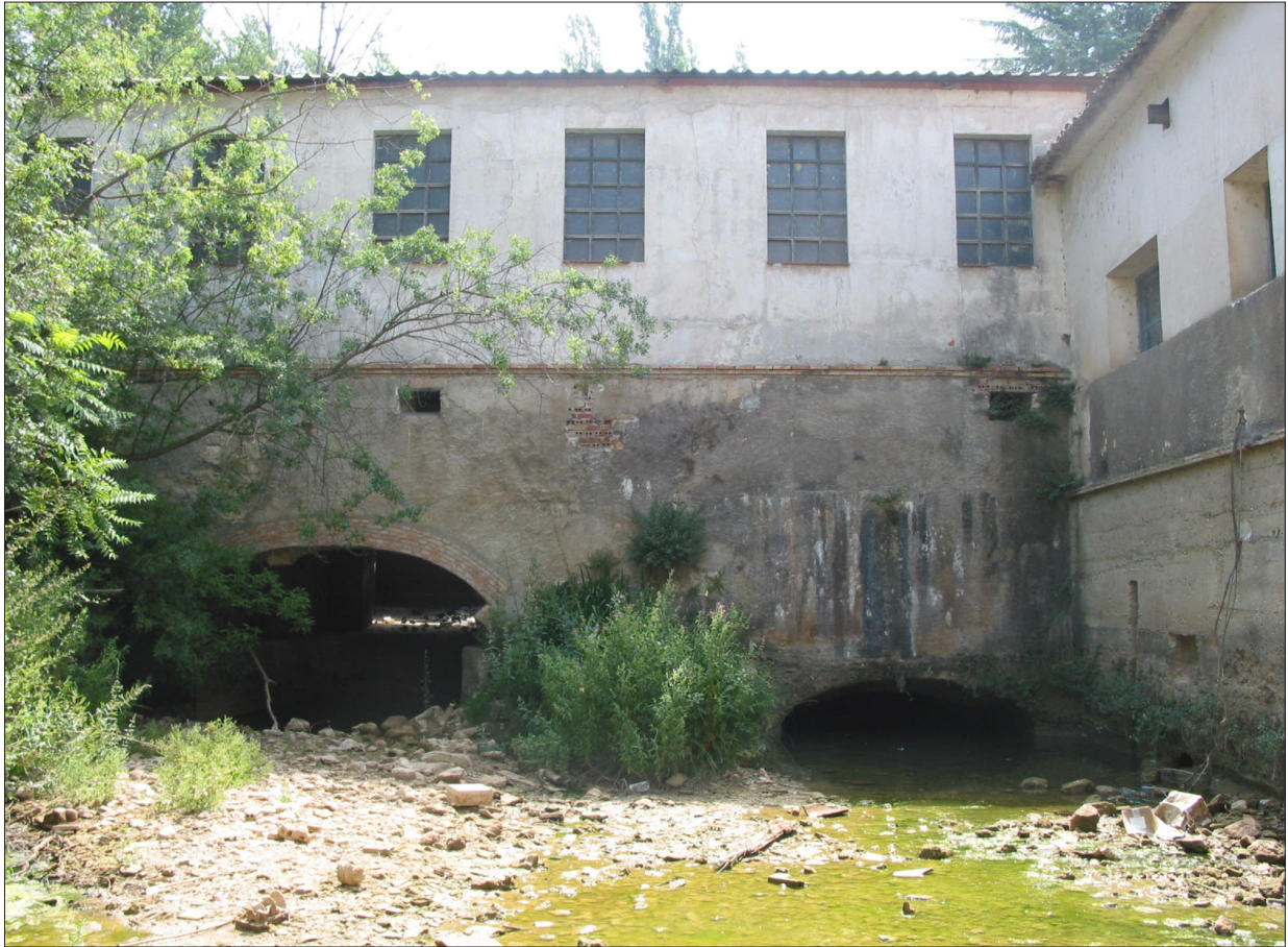
Salida de agua del canal por debajo del edificio.
