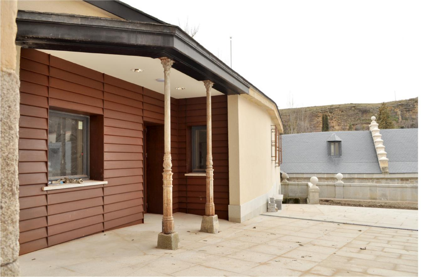
El cuerpo de guardia al final de la obra en 2011, con paneles de acero cortén sugiriendo madera, y con dos de las columnas de 1915 conservados en situ.
