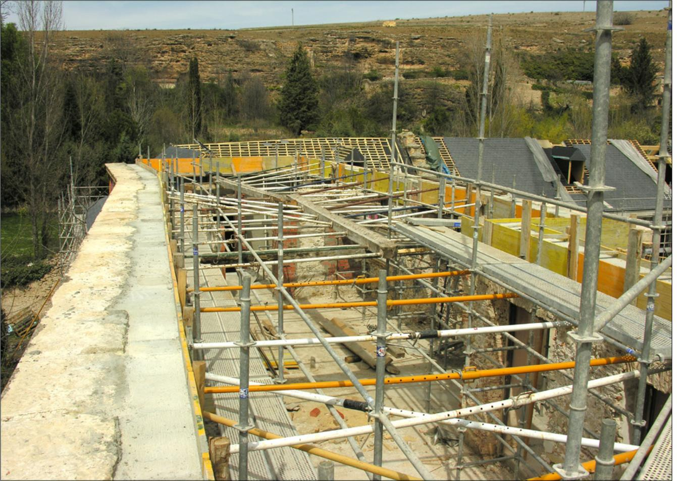
Consolidación de los muros de carga del cuerpo de guardia, en abril de 2008.
